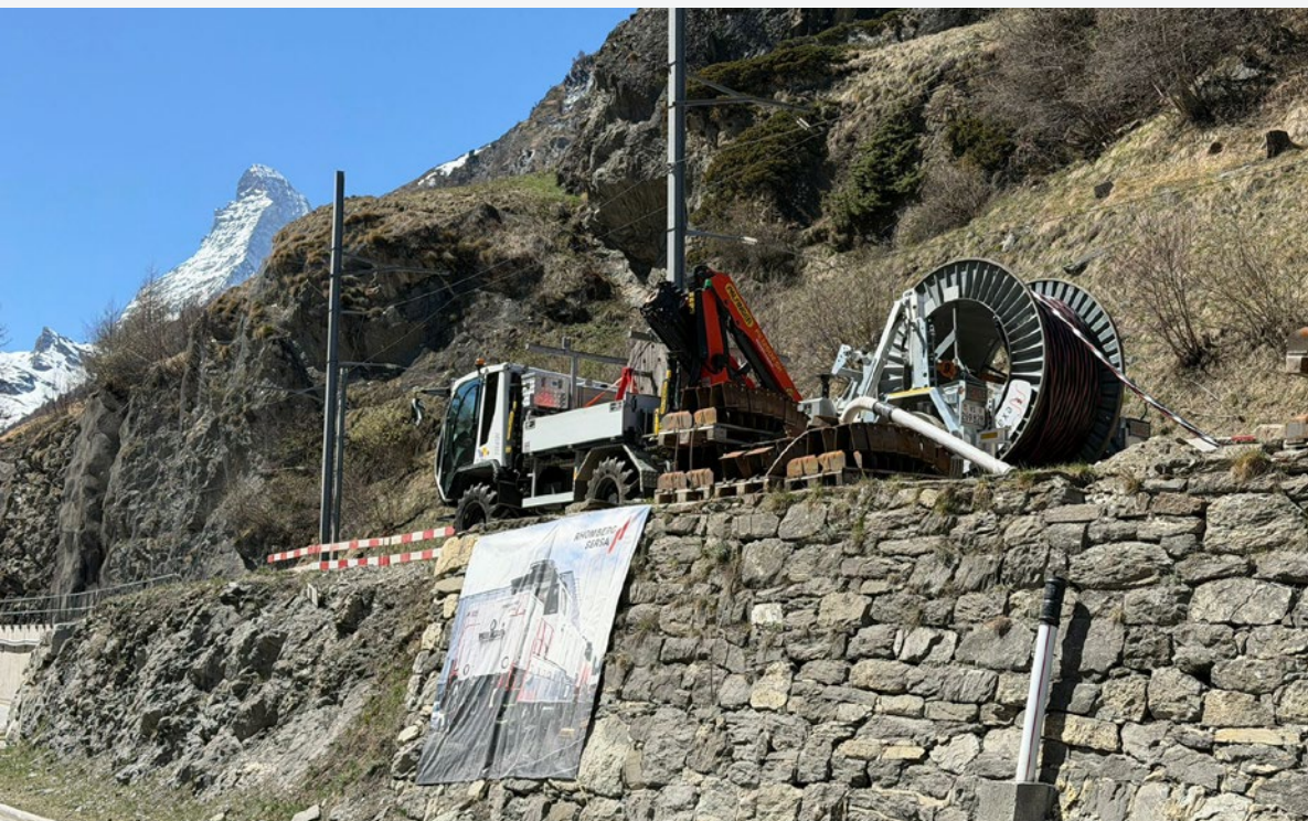
20kV-Kabeltransport und -verlegung für das Provisorium der Strassen- sanierung beim Lüegelti
