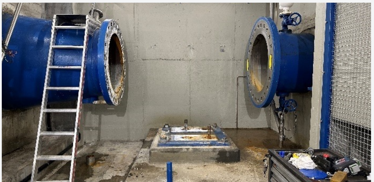
Demontage Kugelschieber
