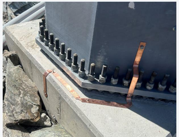
Fertiges Mastfundament mit Ankerschrauben zur Mastbefestigung
