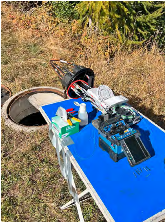
Montage Glasfasermuffe im Feld
