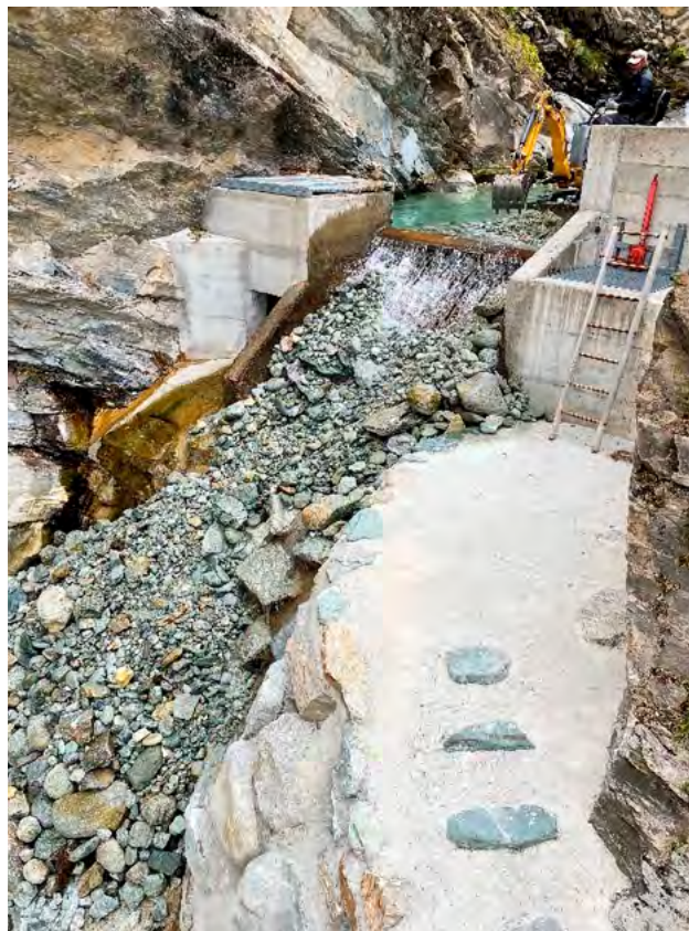
Reinigung Wasserfassung Triftbach
