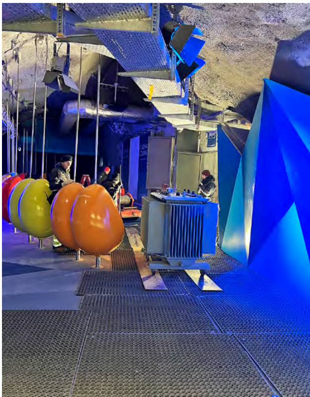
Einbringen Transformator Klein Matterhorn
