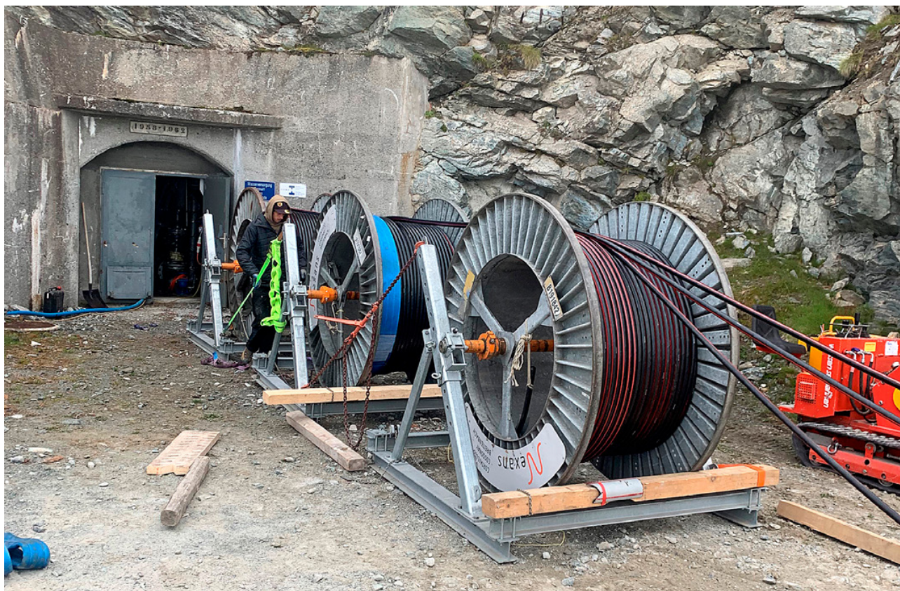
TS Breitboden: Kabelzug 20kV nach TS Riffelboden
