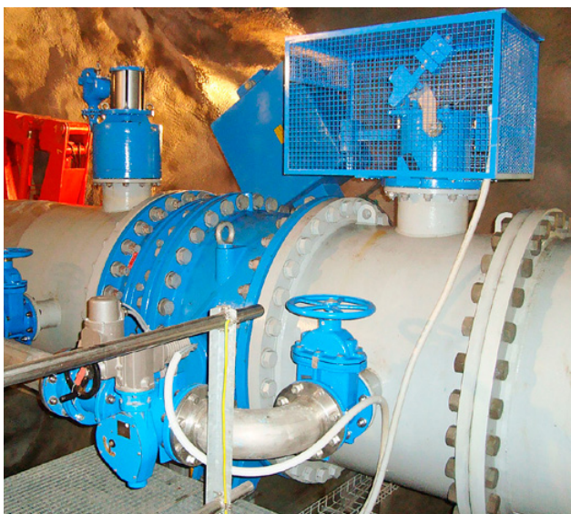
Druckleitung mit Sicherheitseinrichtungen: Apparate-kammer
