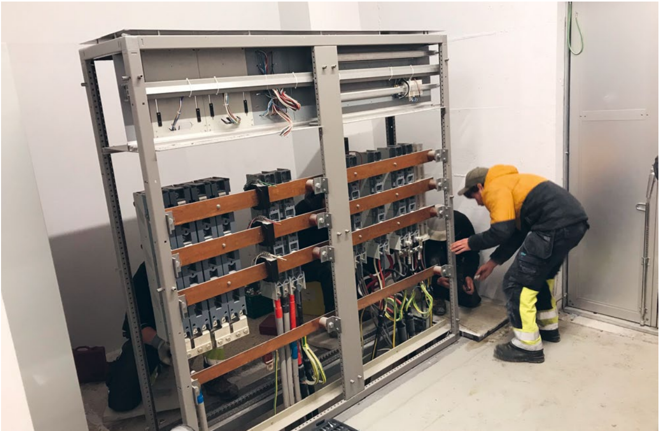
Montage der neuen Niederspannungsverteilung in der Trafostation Wiesti
