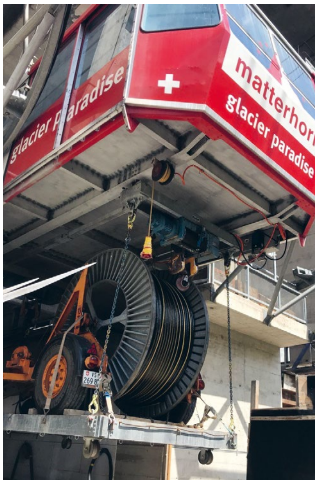
Transport Anschlusskabel für die Bergstation der 3S-Bahn Klein Matterhorn
