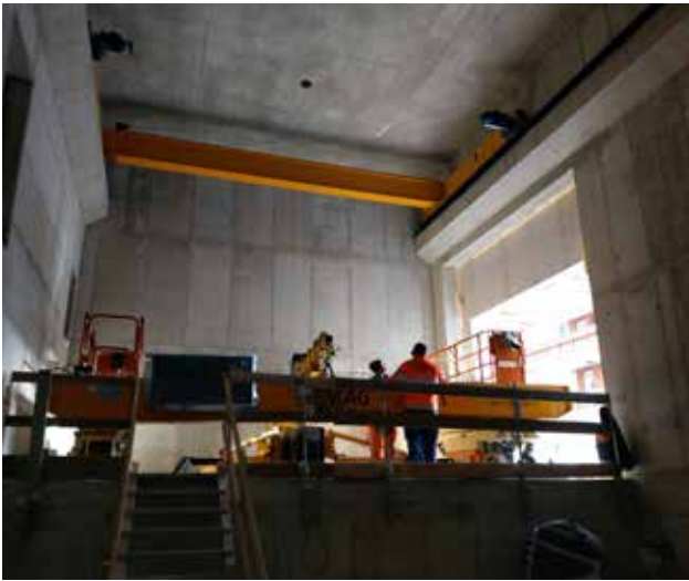
Montage Hallenkran 25 Tonnen
