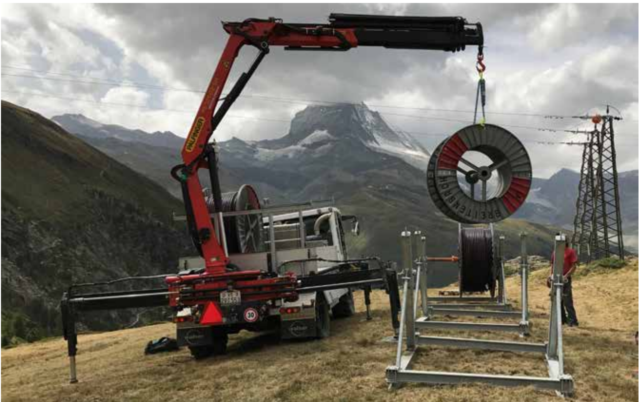
Riffelboden: Vorbereitung Kabelzug
