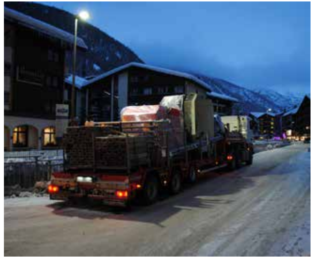
Anlieferung Turbine, Kühler und Kugelschieber
