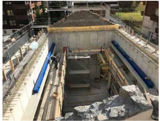
Innenbeton-Hülle und Montage Kranschiene
