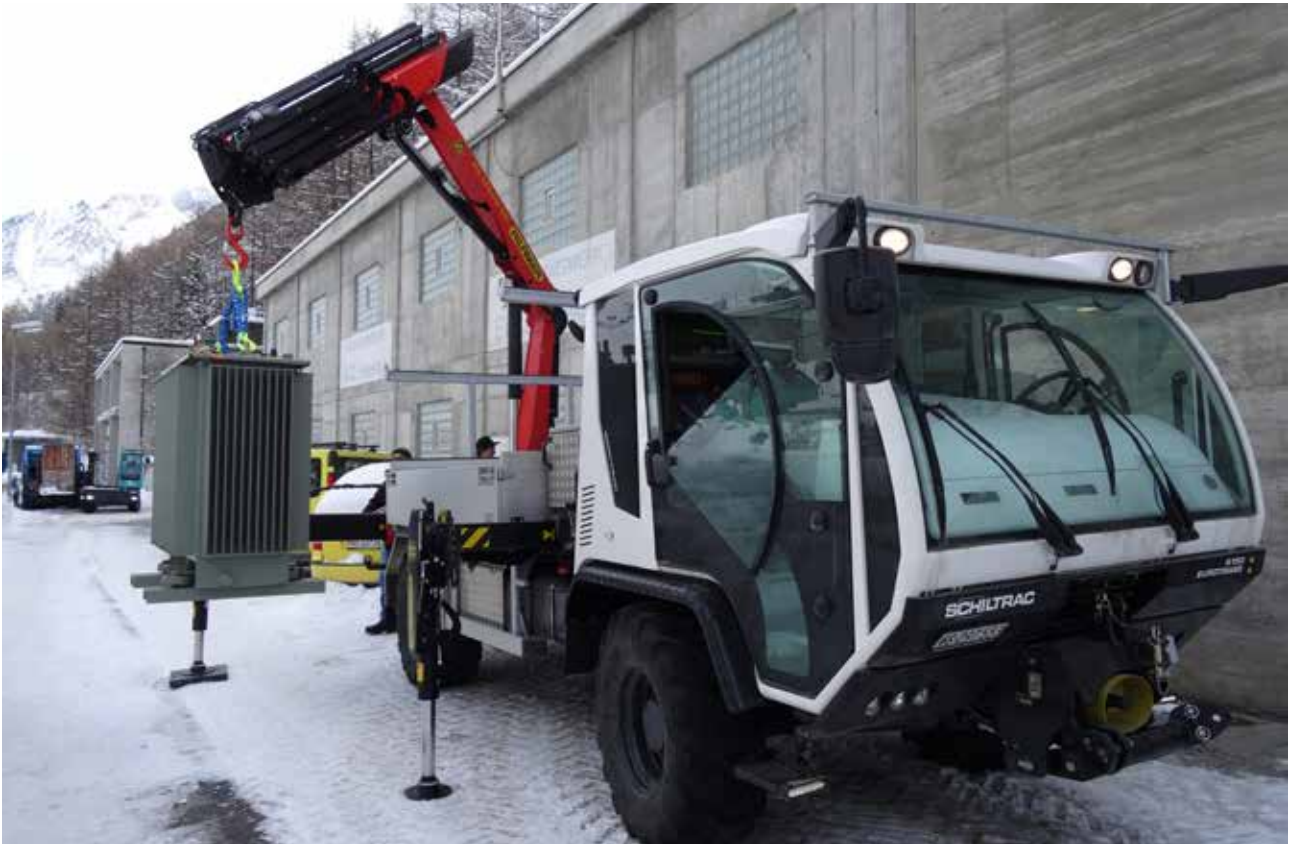
Ablad Transformator mit neuem EW-Fahrzeug
