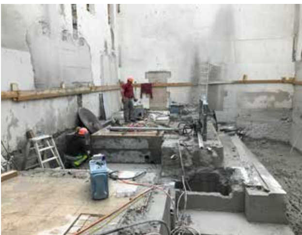
Aufwändiger Rückbau der bestehenden Maschinenfundamente Zieltiefe -2.7m
