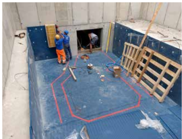
Wanne für Maschinenfundament erstellt, anbringen der Körperschallisolation (blau)
