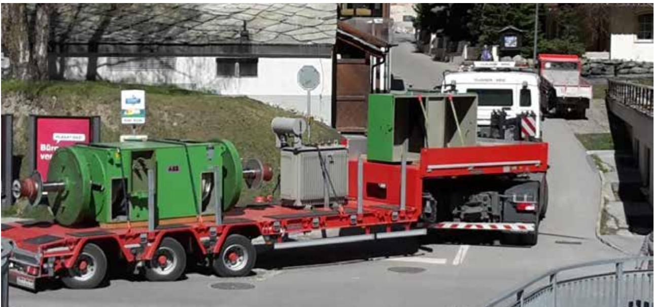
Nach 40 Jahren Betriebszeit Abtransport Generator und Blocktransformator
