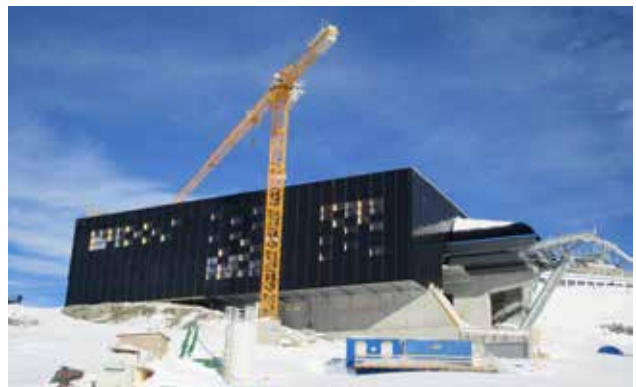
Trockener Steg Aussenansicht (Bild: Solarbau Lowel GmbH)
