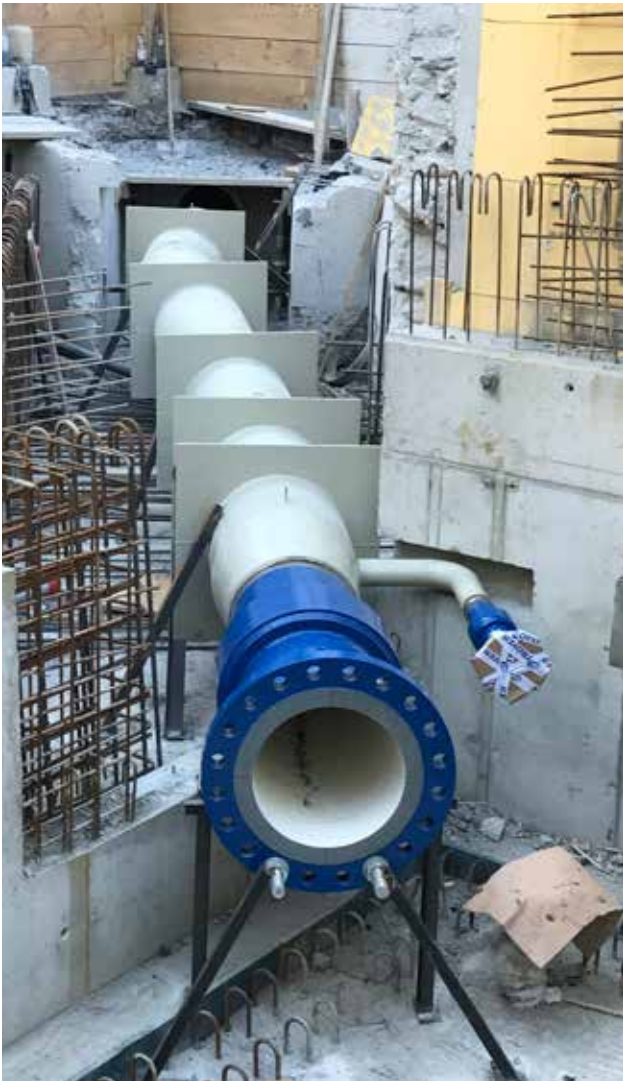
Neuer Druckleitungsanschluss
