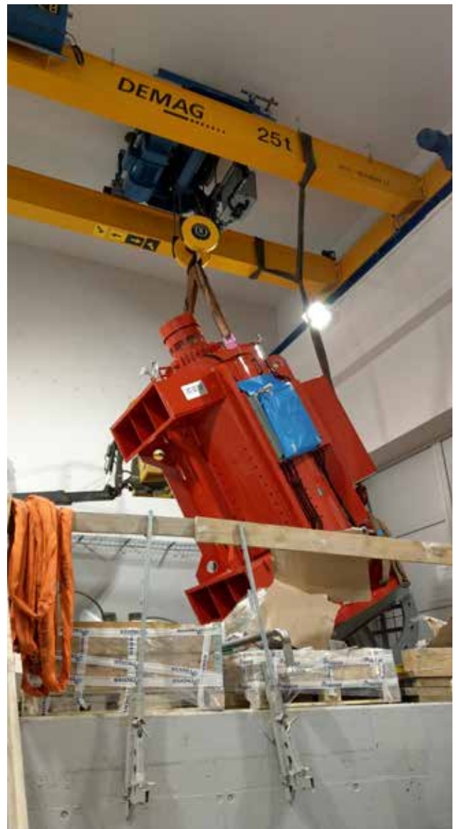
Aufrichten des Generators
