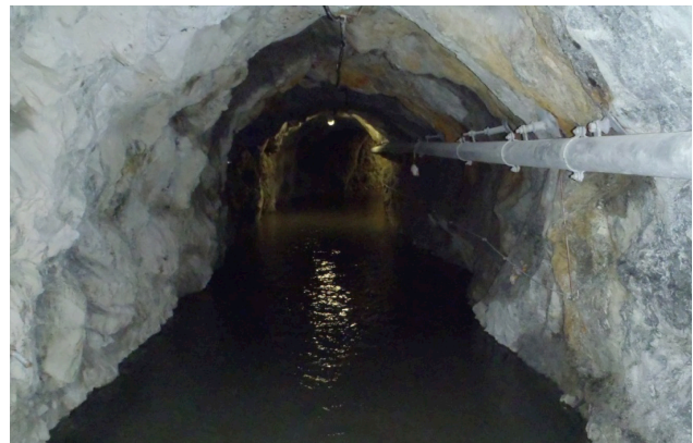
Gefluteter Zugangsstollen Fassung Gornera genutzt als Umleitungsstollen für den Entkieser
