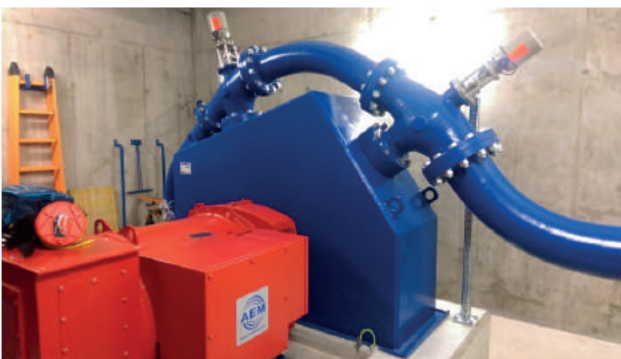
Turbine (blau) und Generator (orange) des KW Mossjensee
