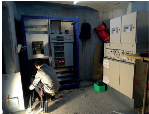
Erstellen Bahnanschluss Seite Trafostation
