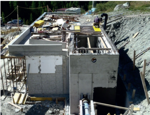
Bau Zentralengebäude (im Vordergrund: Anschluss an Druckleitung)
