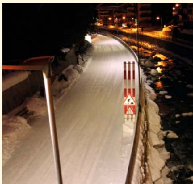
Beleuchtung «neu» LED mit LED 35 Watt • Gleichmässige Ausleuchtung der Strasse • Wenig Streulicht
