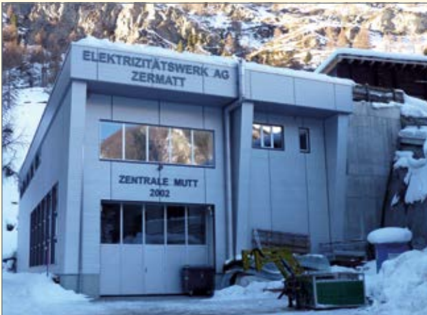
Zentralengebäude KW Mutt Wellenende
