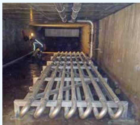
KW Mutt, neuer Kühler im Unterwasserkanal
