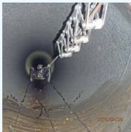
Blick in die Druckleitung mit Inspektionskamera
