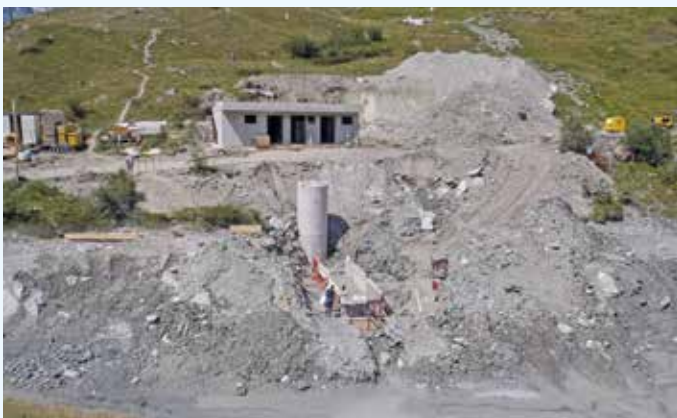
Bau Pumpstation und Fassung Beschneigungsanlage
