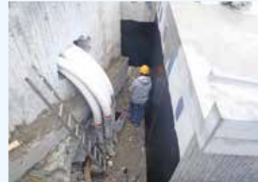
Rohreinführungen „TS Luchern“
