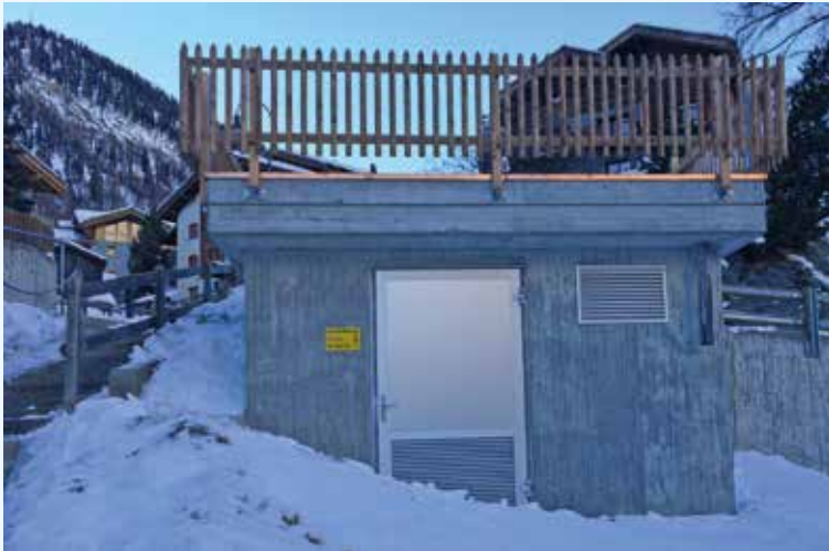
Trafostation „TS Luchern“
