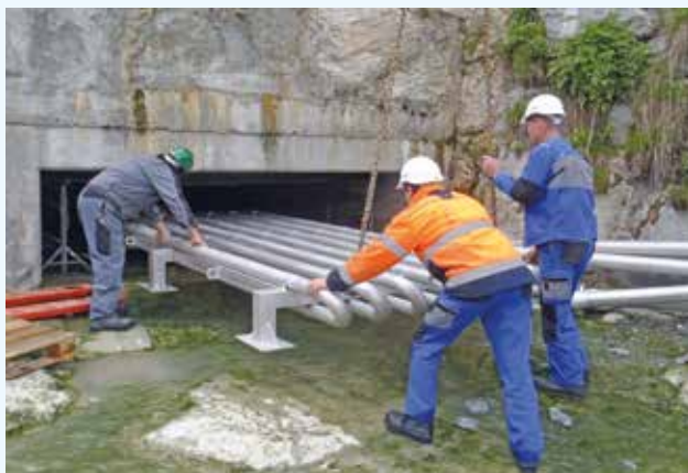
KW Mutt, Montage Kühler
