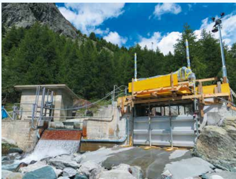
KW Wiesti, Wasserfassung Findelbach Montage des Hauptschiebers
