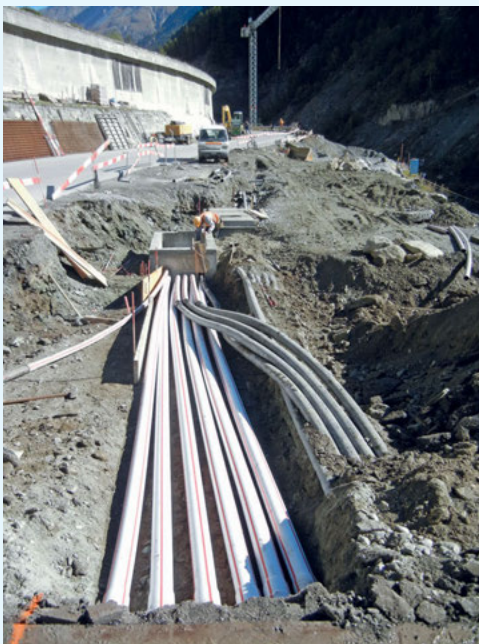
Lügelti; Rohrblock im Strassenkörper
