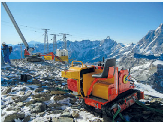
Baustelleneinrichtung Plateau Rosa
