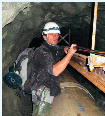
Verlegung Glasfaserkabel im Stollen Findeln - Bleiktola
