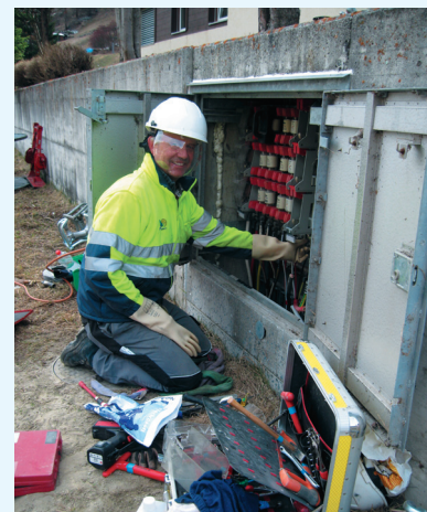
Erstellen Netzanschluss an Verteilkabine
