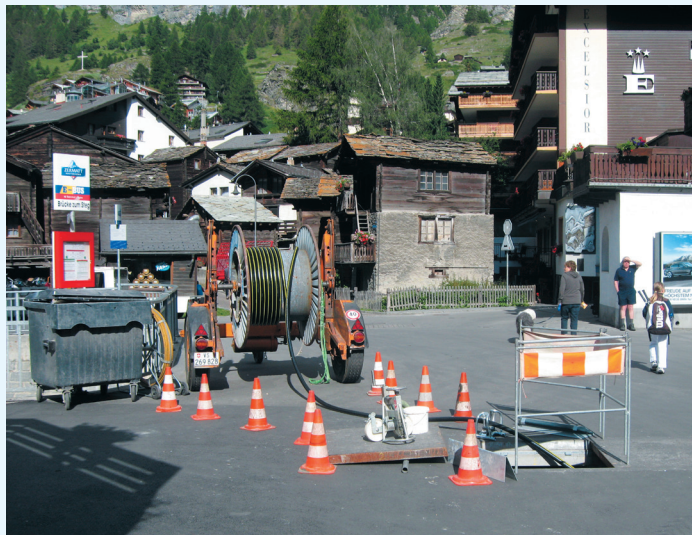
Kabelzug in Zermatt
