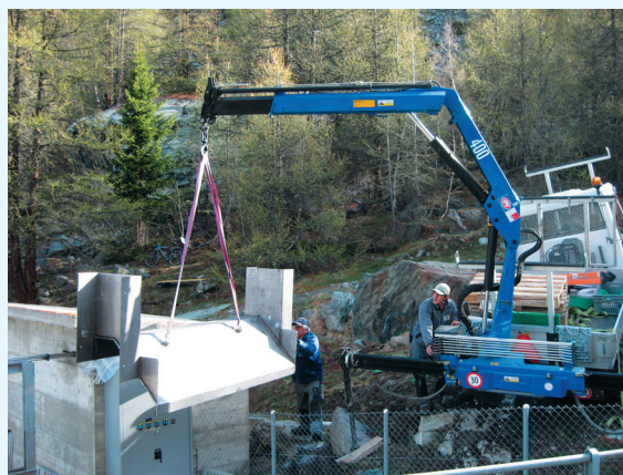
Montage Überlaufkanal Fassung Findelbach
