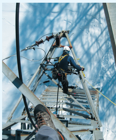
Leitungskontrolle in luftiger Höhe
