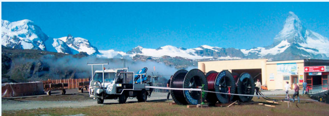
Kabelzug MS-Kabel Blauherd - Tufternalp
