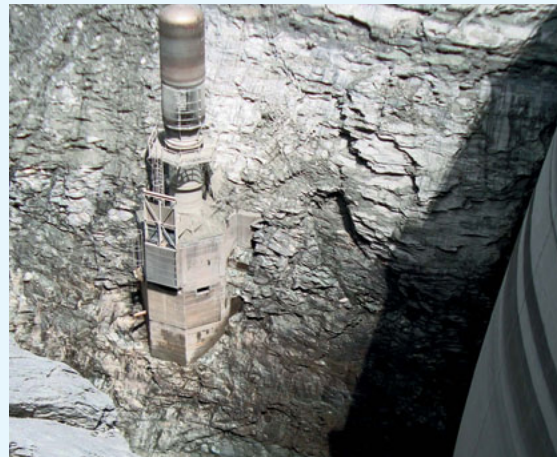
Schwimmende Wasserfassung im Staubecken der Grande Dixence; Werk Zmutt (rechts: Bogenstaumauer)
