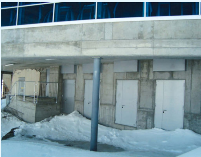
Trafostation „Trockener Steg 1“
