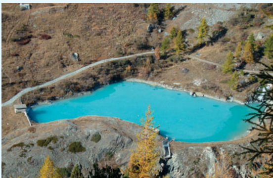
Speicherbecken Mosjensee des KW Wiesti
