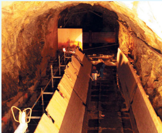
Aquädukt über den Entkieser der Fassung Gornera
