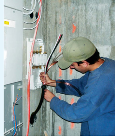
Erstellen eines Hausanschlusses
