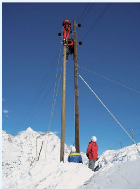
Störungsbehebung an einer Freileitung
