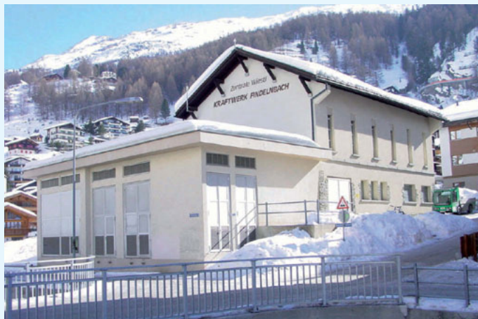
Zentrale des Kraftwerks Wiesti
