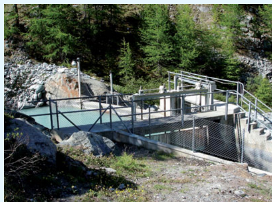
Wasserfassung des KW Wiesti am Findelbach
