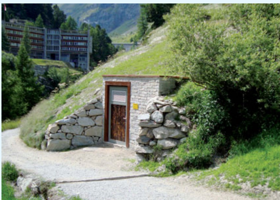
Neue Trafostation „TS Zmutt“
